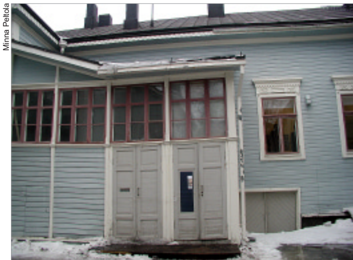
Korjausrakentamisen laboratorio Korsu sijaitsee Oulun kauppatorin kupeessa Rantakatu 2:ssa. Ulkoapäin talo kaipaa vielä kunnostusta, mutta sisäpuoli on korjattu kauniiksi.
